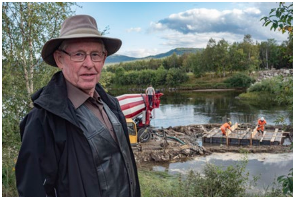
Drøm blir nå virkelighet. Initiativtager bak Nebybrua, Ola Grønn Hagen, kan endelig konstatere at byggingen er i gang
