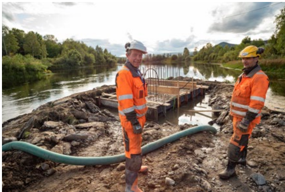
Knut Kolbu (t.v.) og Per Sønsmør i SK-Bygg AS utfører betongarbeidet på brua før isen legger seg på elva. Sønsmør lagde selv ei pumpe av gamle møkkvognedeler, som brukes i arbeidet med Neby-brua
