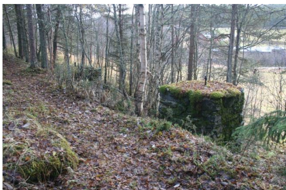
Taubanefundament ved Sagmoen
