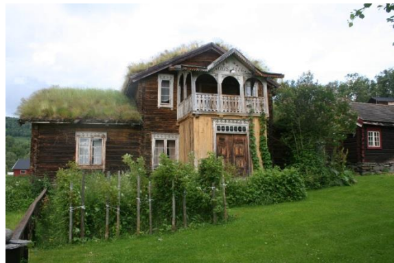
Østerdalsstua i Neby Bortistua har et merkelig barfrø, 1 ½ etasje i reisverk, stua er dessuten utvidet med langkammers og loft, dessuten et 1 ½ barfrø. Kaffekvernbygd Dalen veranda fra 1886, t h. den gamle østerdalsstua
