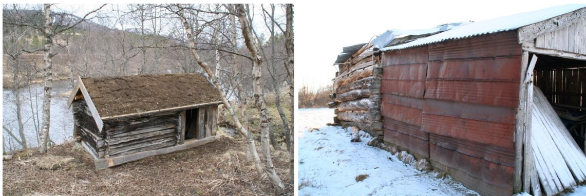
Løe ved Orkla, Grøtli, på veggen står:.. paa Luffen til Sundsvall Sverige» Løe Børli, tømmerløe forlenget med reisverk kledd med blekkplater
