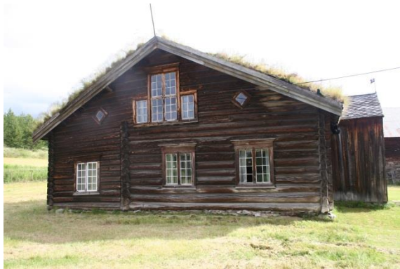
Østerdalsstua i Neby Bortistua har et merkelig barfrø, 1 ½ etasje i reisverk, stua er dessuten utvidet med langkammers og loft, dessuten et 1 ½ barfrø. Kaffekvernbygd Dalen veranda fra 1886, t h. den gamle østerdalsstua
