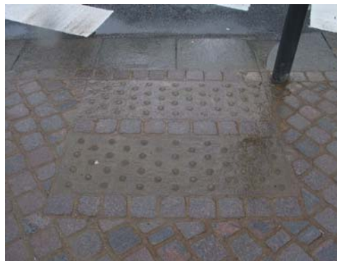
Forslag til løsning av taktilt belegg ved fotgjengerovergang. Eksempel på taktilt belegg for synshemmede til høyre.
