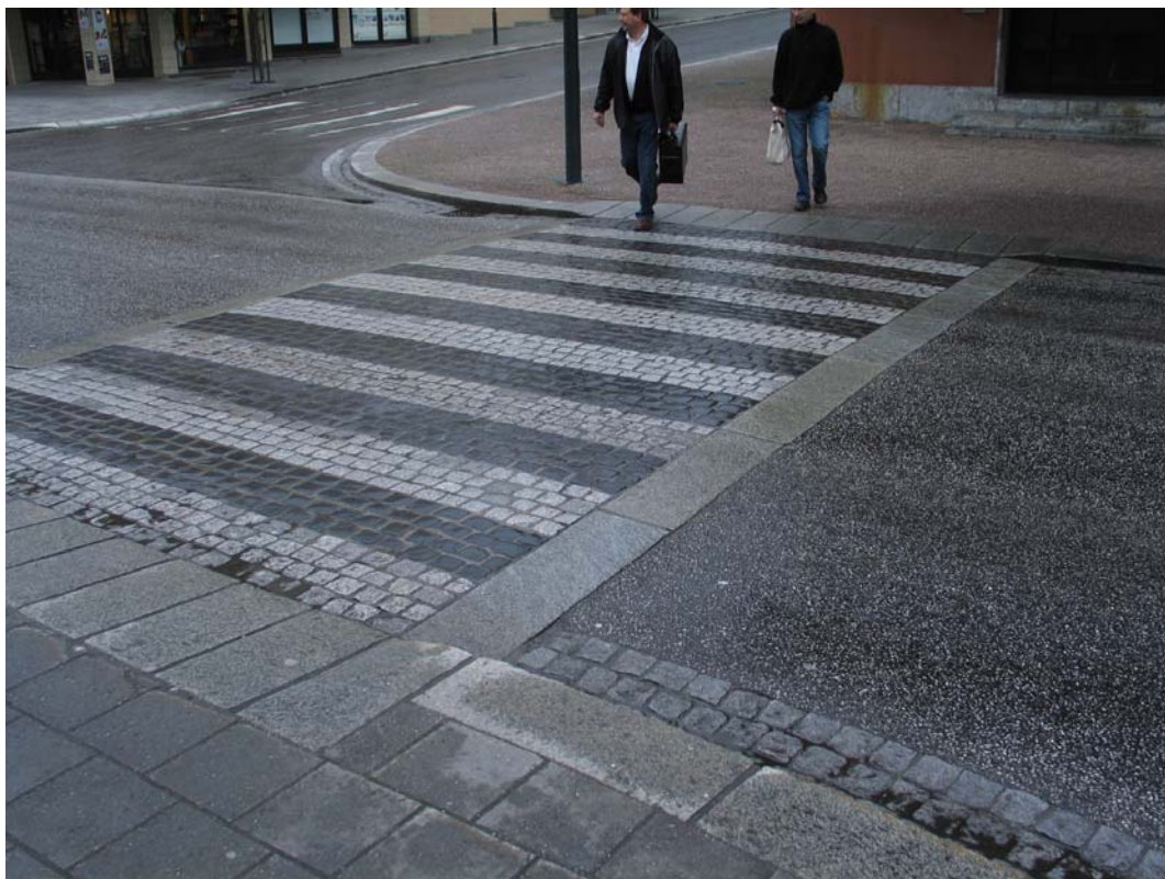
Bildet (fra Molde) viser utførelse av opphøyet fotgjengerovergang i sentrumsområde. Det er nedsenket kantstein, og tverrstriper er markert i belegningsstein. Det er langsgående markering med 2 rader stein langs kjørebanen.
