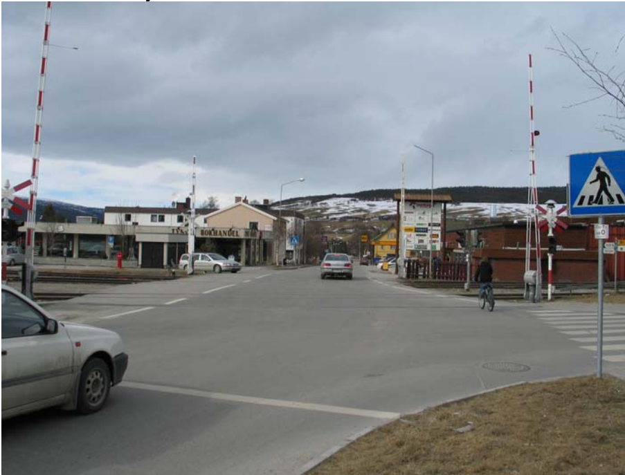
Dagens situasjon ved jernbaneovergangen midt i sentrum
