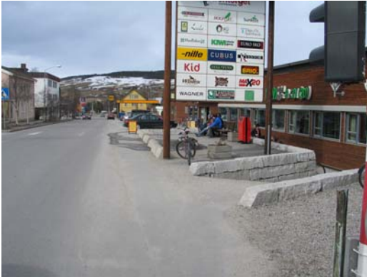
Eksempel på natursteinsmur foran Trontorvet som ikke er tilpasset situasjonen mht detaljering eller bearbeiding.
