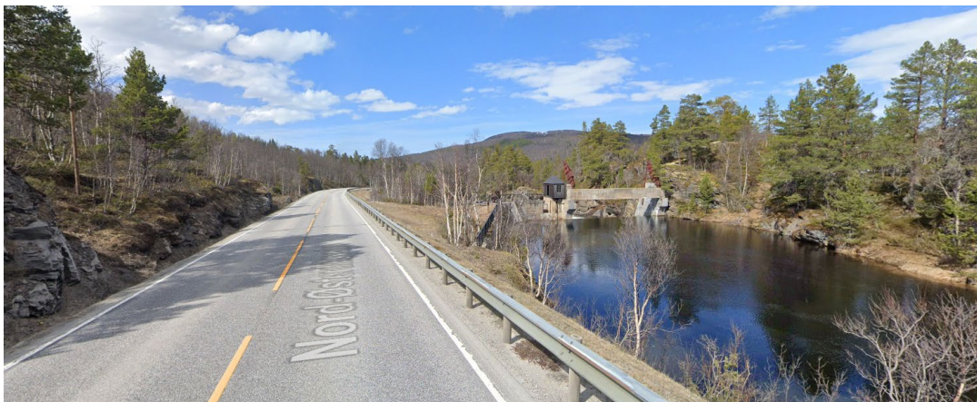
Foto: Rv 3 ligger nære inntil Orkla bare to steder på strekningen; Dammen Kilde: 9 Nord-Østerdalsveien - Google Maps
