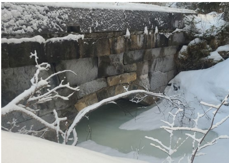
Eldre steinvelsbru på gammel vegsløyfe vest for riksvegen blir ikke påvirket av prosjektet, men dersom flom-og vannlinjeberegningene viser at steinhvelsbrua kan forårsake oppstuvning av vannmasser, så er det aktuelt å se på tiltak, for eksempel etablering av overløp.
