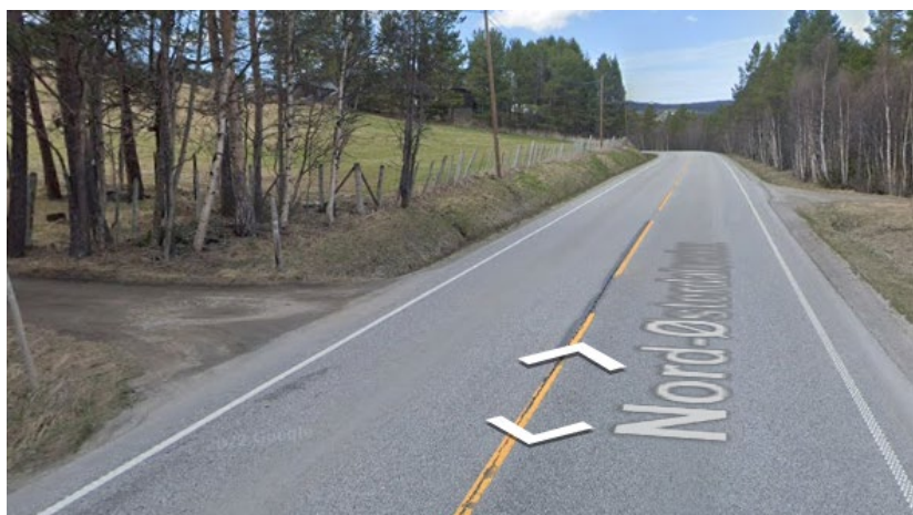
Ved profil 4400: Eksisterende avkjøringer opprettholdes. Bedre grøft vil kreve noe stripeerverv av dyrka mark.
