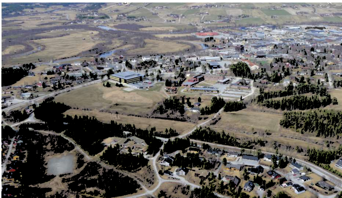
Oversiktsbilde fra sør mot nord
