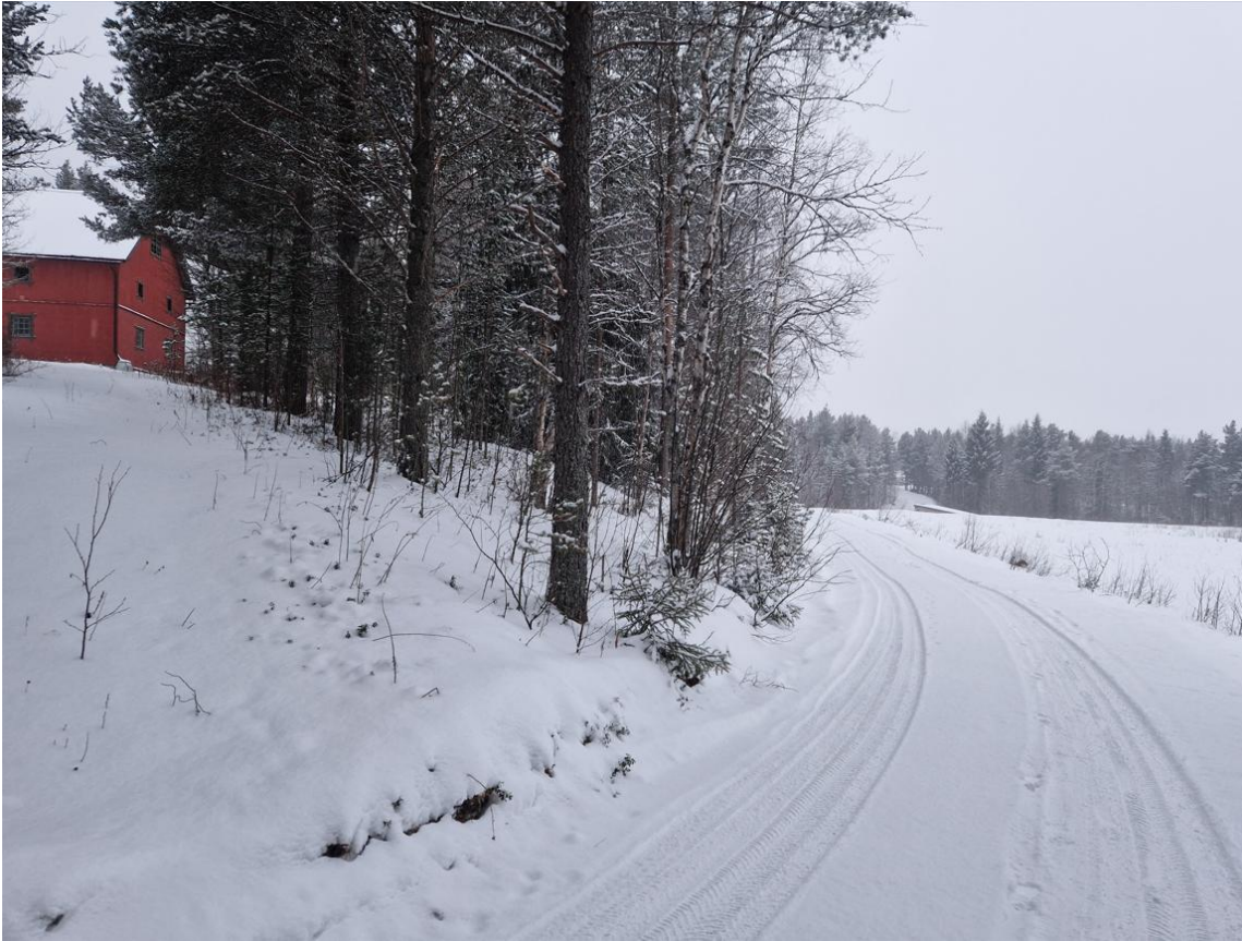
Figur 4-6 Byggeområdet sett fra sørøst mot vest. Bildet viser låve som skal rives. Foto Norconsult 2024
