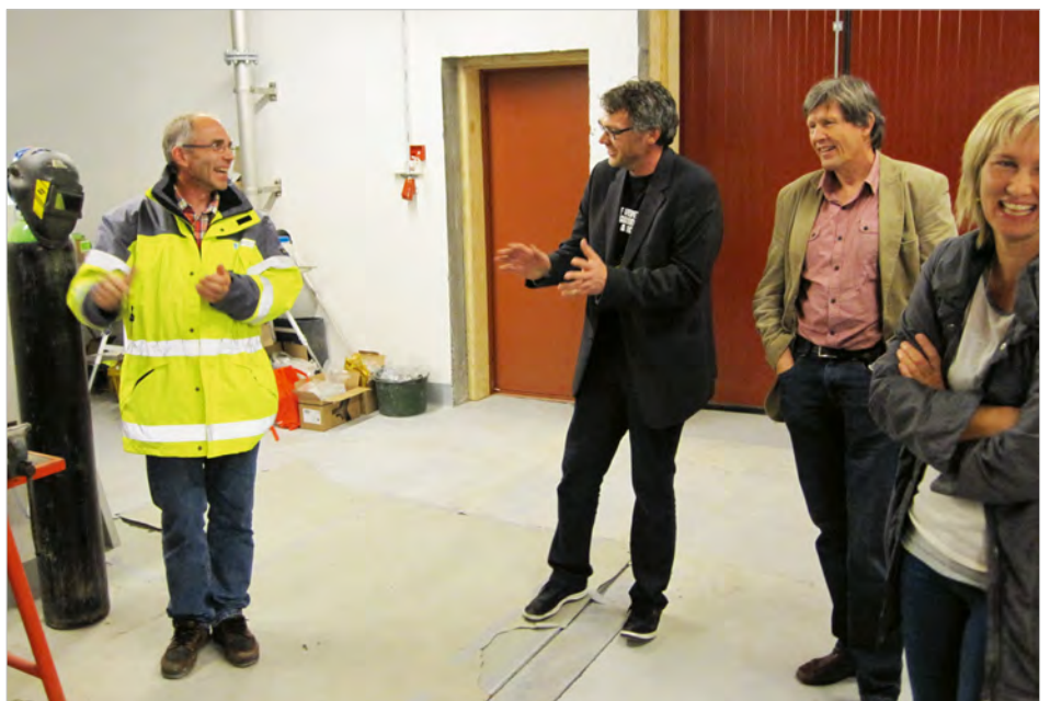
Driftsleder i uteseksjonen Svein Magne Storås orienterer formannskapet under befaring i det nye renseanlegget
