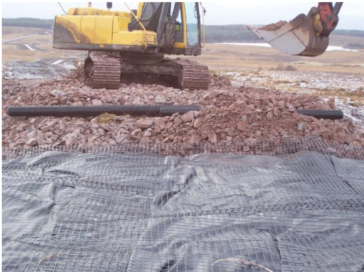
Bilde av utlegg av geonett
