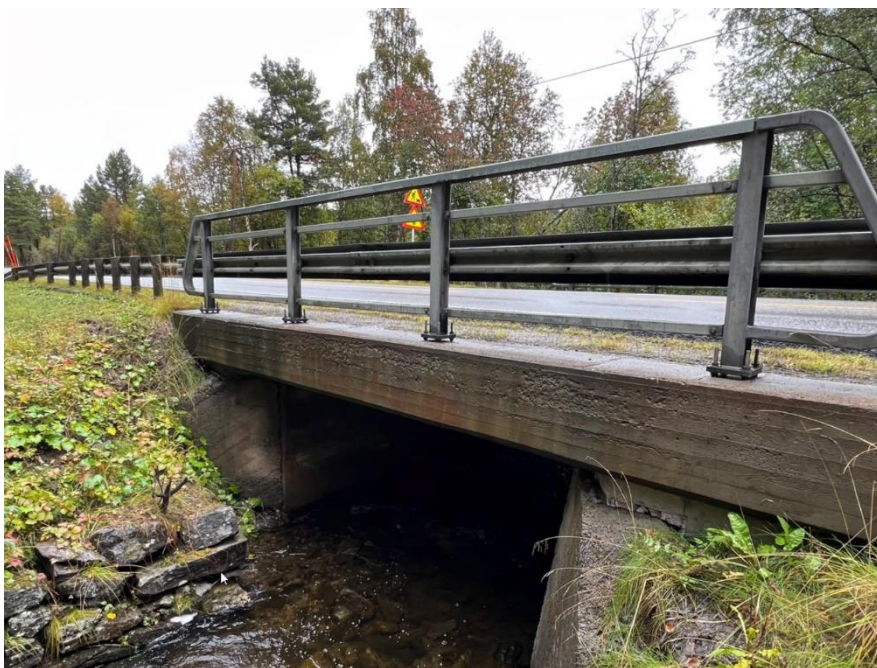
Figur 4.3. Bildet viser innløp - Fuglåsbecken (Foto: Hanne Saug Lie).
