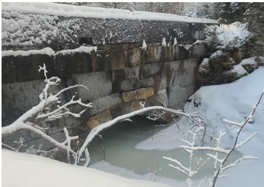
Figur 4.1. Bildet viser innløpet til steinhvelvsbru, oppstrøms Rv. 3 - Hyllebekken (Foto: Einar Aakerøyen).
