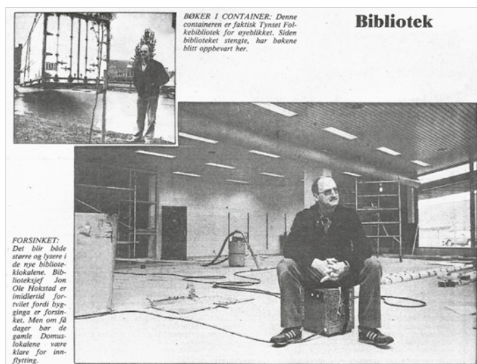
I 1987 var Tynset bibliotek pakket ned i containere. Biblioteksjef Jon Ole Hokstad i forgrunnen
