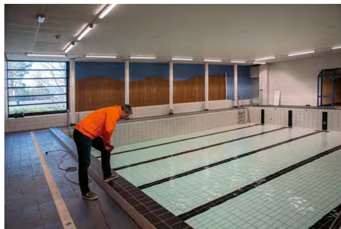
Teknisk sjef Jostein Hauge konstaterer at bassenget er klart til å fylles med vann. Fire dager tar det å fylle et 12,5-meter basseng
