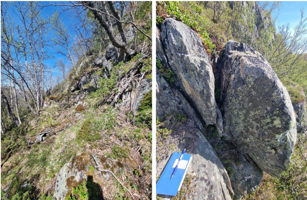
Figur 21: De bratteste partiene i fjellsiden mot nord, som er definert som løснеområde for steinsprang, har generelt helning lik eller mindre enn 45°. Det er kun mindre områder som er brattere enn 45° for øvre del av fjellsiden, som kan sees i Figur 22 (venstre). Det er observert sprekkeavløste blokker i fjellsiden, både på befaringen til fots og ved drone.
