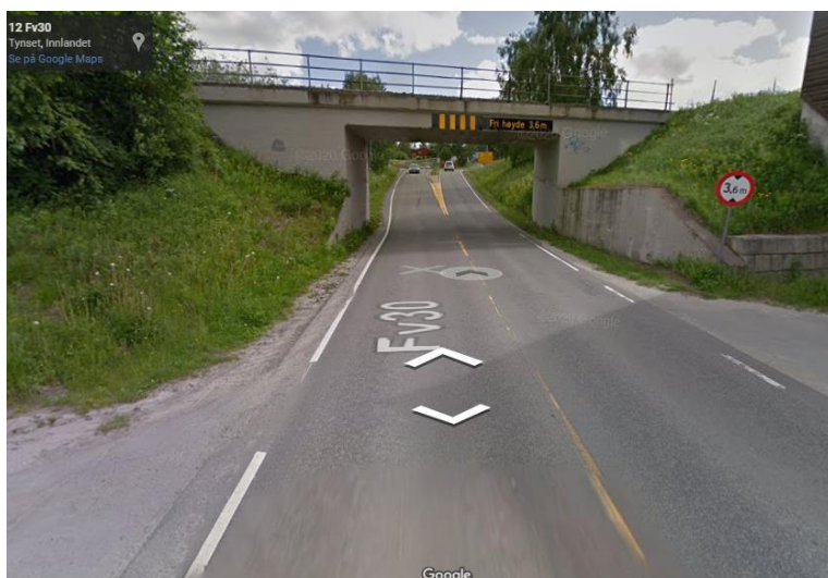
Figur 4-19: Kulvert under Rørosbanen sett mot rundkjøring i krysset mot Parkveien (Google Streetview)
