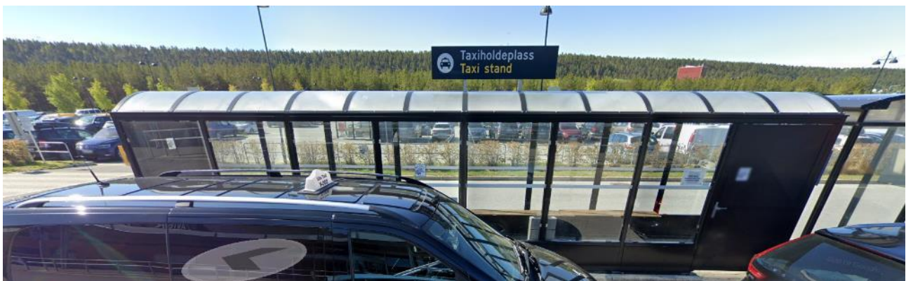
Figur 6-8 Bilde viser oppvarma holdeplass v/Alta lufthavn. Kilde: Google maps, bilde tatt juni 2019.
