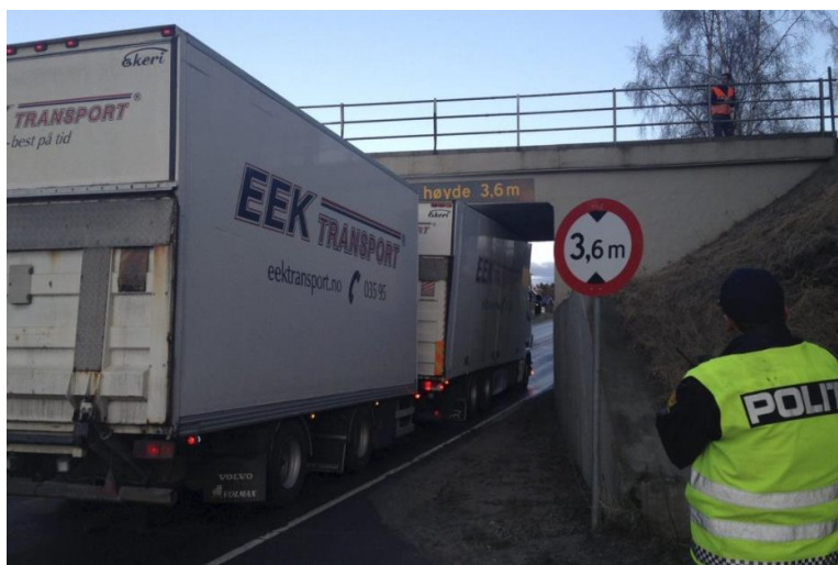
Figur 4-20: Bilde fra ostlendingen.no der kjøretøy har satt seg fast i undergangen på Ringvegen (fv. 30) (Østlendingen)
