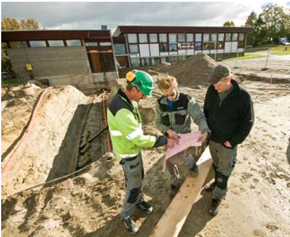
Utbygging ved Tynset barneskole. Fra venstre: Finn Rønning (SK-Bygg AS), Odd Gunnar Jevnaker og Arild Høye (begge fra Tynset Varme og Sanitær AS). Foto: Ingrid Eide.
