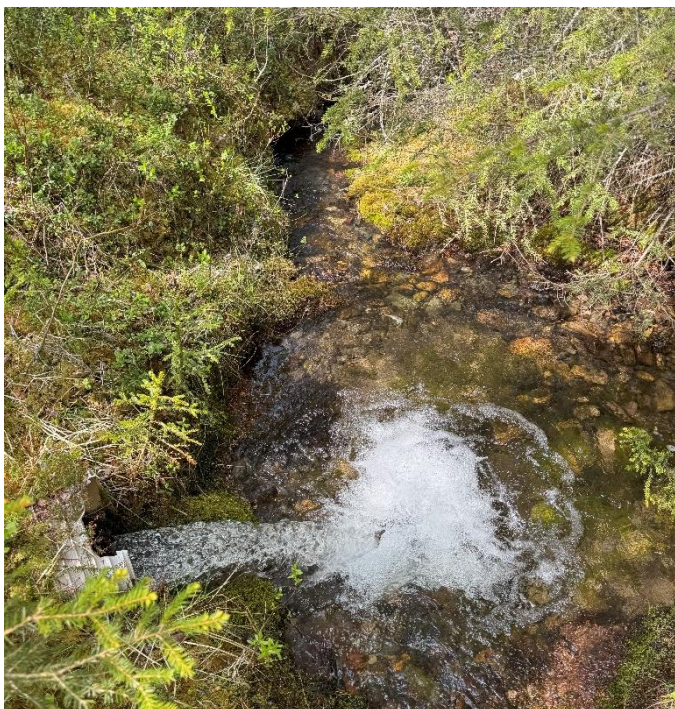
Figur 4: Ø300 mm overvannsrør som fører overvann inn på Myrvollbekken.
