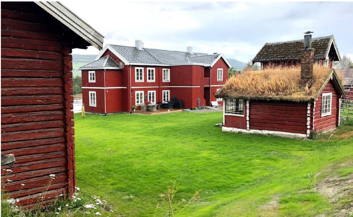
Bilde av dagens tun på eiendommen
