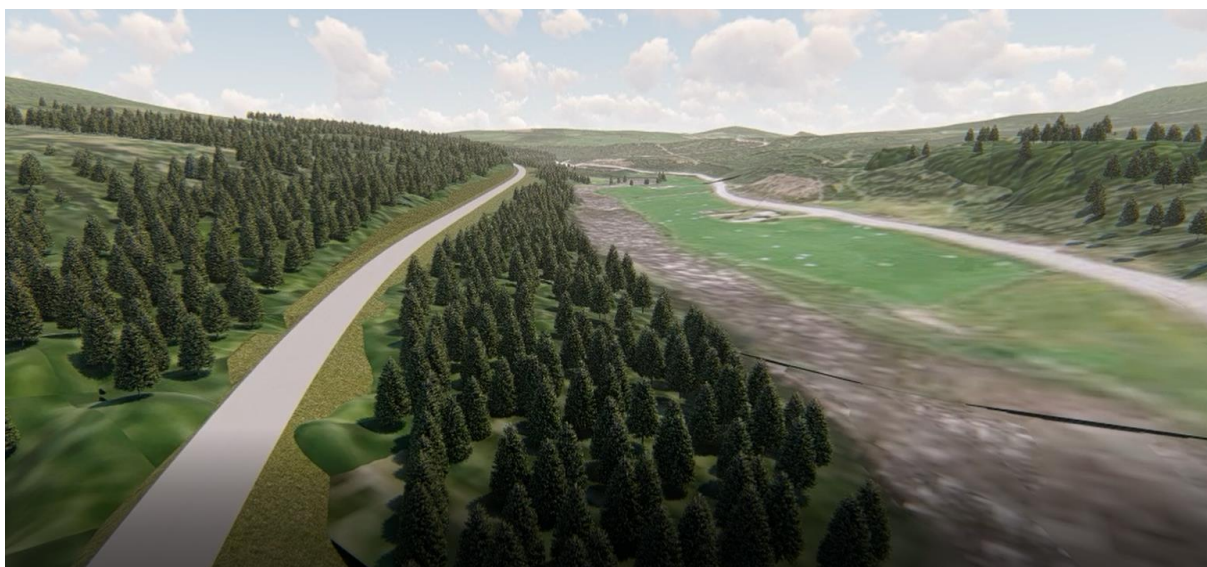
Figur 3 3D-visualisering av vegtiltaket. Den nye riksvegen ligger med en stivere linjeføring på vestsiden av dalen.
