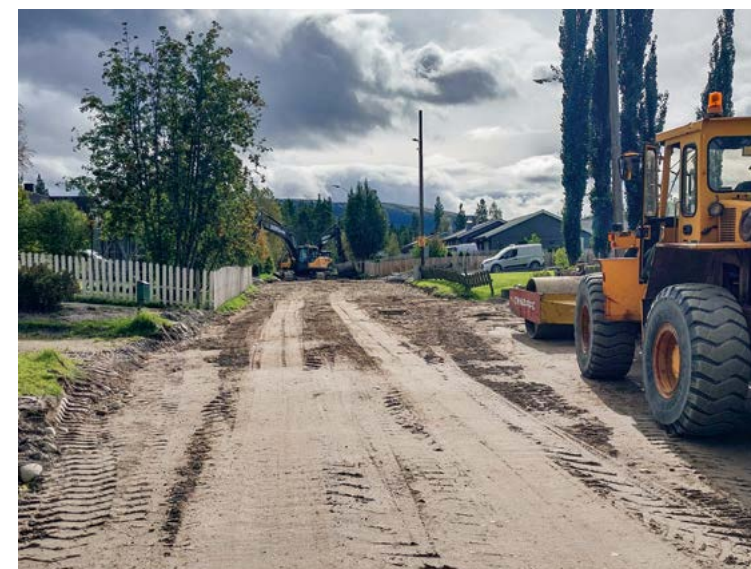
Nytt fortau i Idrettsveien i løpet av våren 2025
